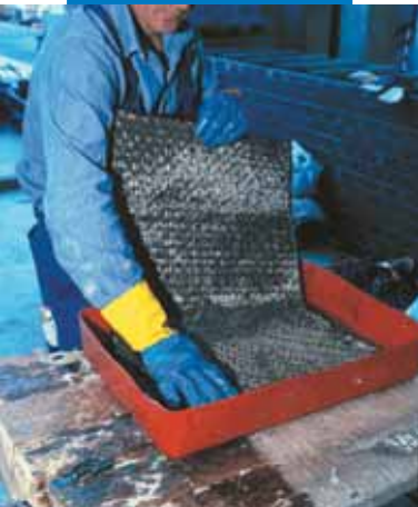
Impregnación manual de MapeWrap C
